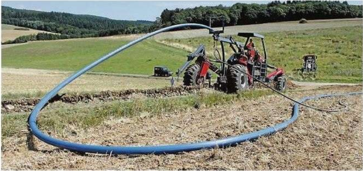
Mit einem geländegängigen Fahrzeug wird die Leitung im so genannten Kabelpflugverfahren in die Erde gebracht.
